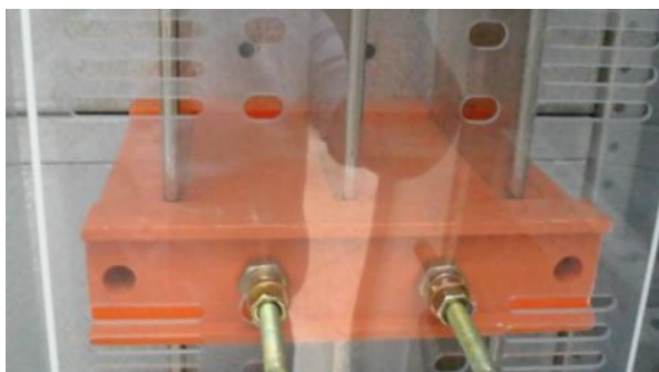
配电母排母线夹照片
