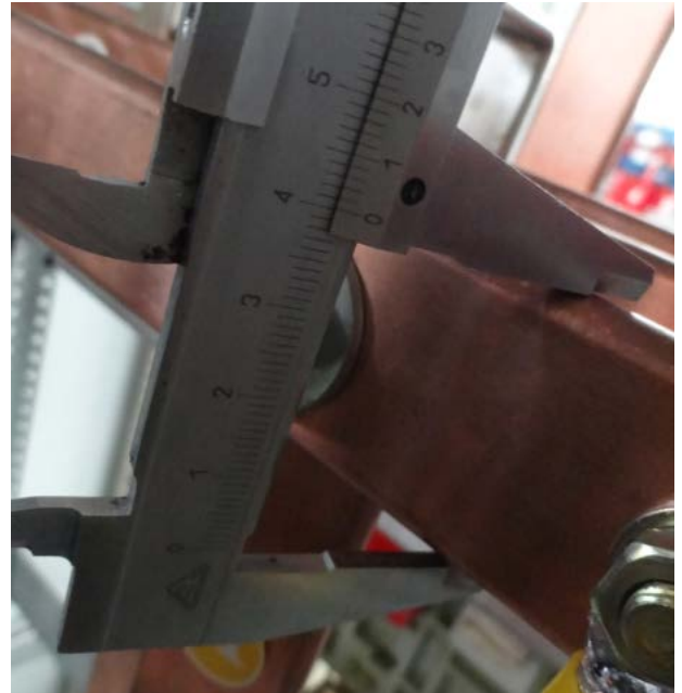
主母线宽度照片
