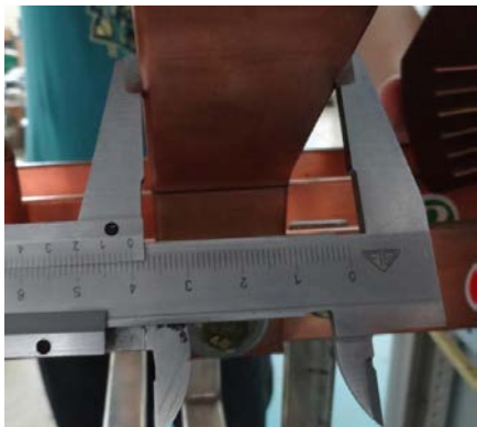
主母线宽度照片
