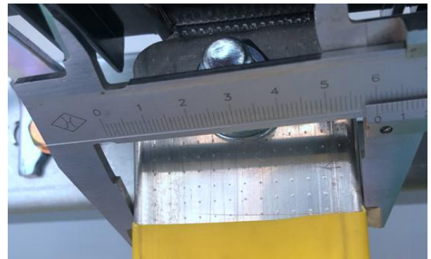
主母排宽度照片
